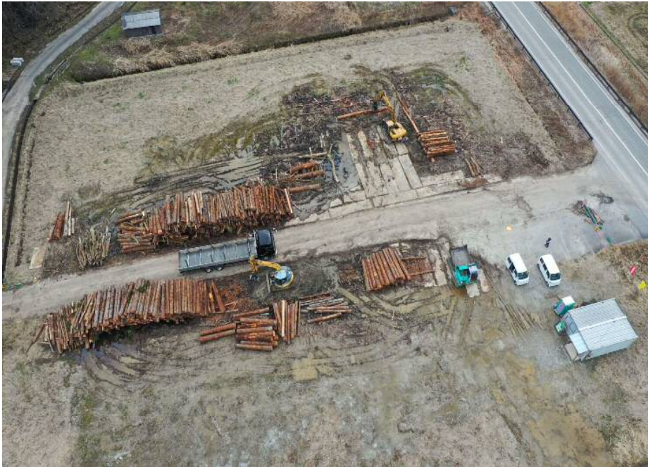
宇波団地中間土場での積込作業と現場管理事務所
