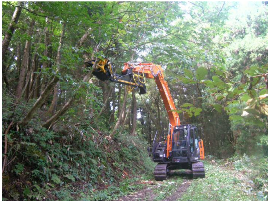
フェラバンチャによる伐採作業
