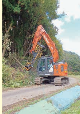
【南砺市樋瀬戸地内】 既設道沿いの支障木伐採
