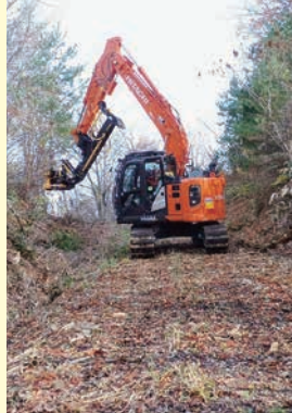
【高岡市石堤外地内】 既設道沿いの支障木伐採
