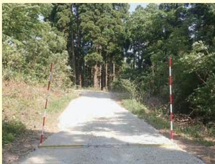
【高岡市福岡町加茂・馬場地内】 既設道補強
