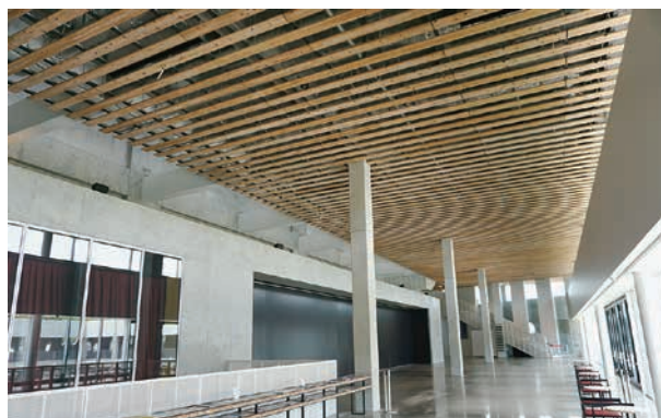
2Fエントランスロビー（ひみ里山スギ：天井部）
