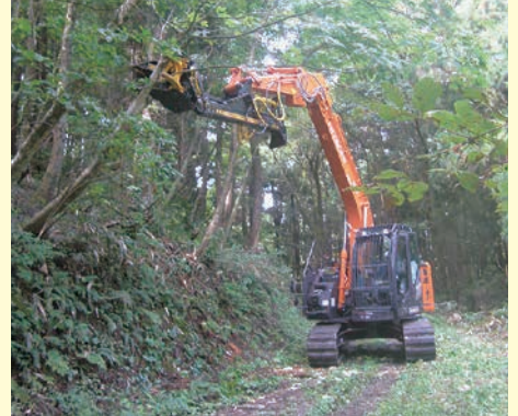
【南砺市川西外地内】 既設道沿いの支障木伐採
