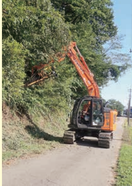
【高岡市福岡町上向田外地内】 既設道沿いの支障木伐採
